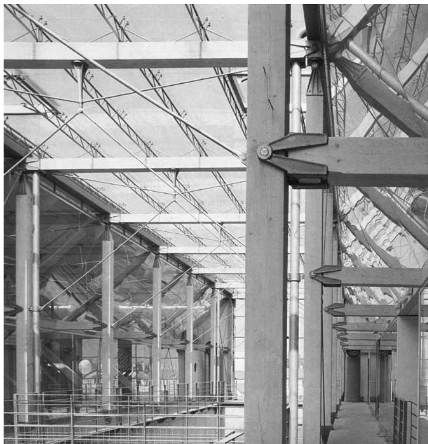
École d'architecture de Lyon, à l'étage, vue perspective sur les ateliers et la rue intérieure.
