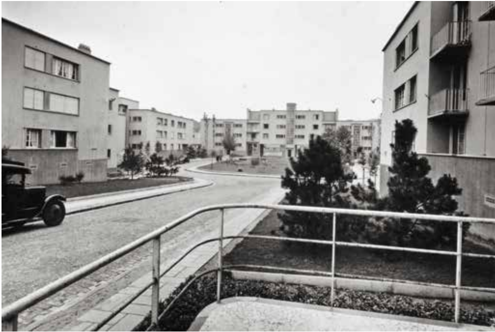
Construction de la tranche 1 et de la tranche 2, années trente. 1 - Livraison de l'avenue Albert-Thomas. 2 - À l'arrière-plan, l'immeuble-tour, signal d'entrée de la cité-jardin. 3 - Les immeubles en service, place Jean-Allemane.
