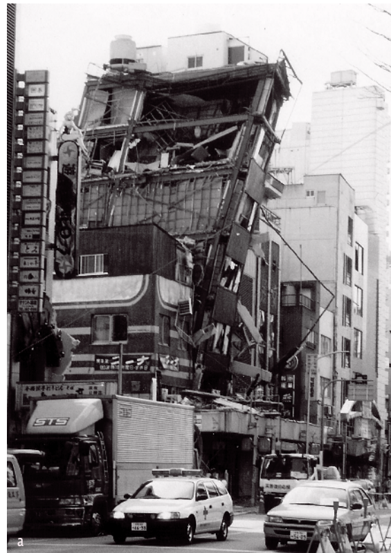
FIG. VII • 1 Dommages sismiques aux bâtiments dus à la résonance avec le sol. a Séisme de Kobé, Japon 1995, magnitude 7,2. b Séisme du Mexique, 1985, magnitude 8,2.
