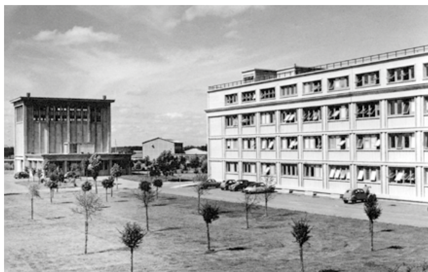
Auguste Perret, Centre d'études nucléaires, Saclay, plan de masse, 21 juillet 1948. Les bâtiments et l'accélérateur Van de Graaff, 1953.
