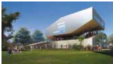
Futur centre social de l'Arbrisseau.
