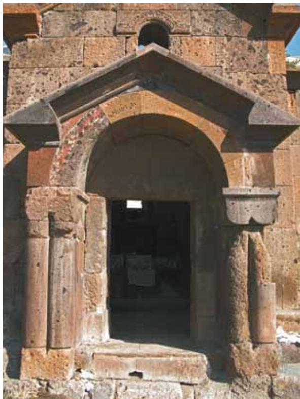
FIG. 272 OCHAKAN, CHAPELLE QUARANTE MARTYRS. PORTE SUR LA FAÇADE OUEST.
