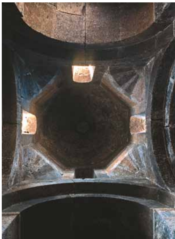
FIG. 224 ACHTARAK, SAINTE-MÈRE-DE-DIEU. VUE INTÉRIEURE SUR LES TROMPES ET LE TAMBOUR.
