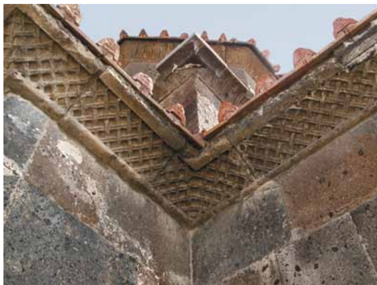
FIG. 223 ACHTARAK, SAINTE-MÈRE-DE-DIEU. CORNICHES DU HAUT DES MURS ET DU TAMBOUR.
