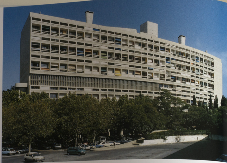
1 Page précédente : vue générale de la façade est donnant sur le boulevard Michelet. Le noyau des escaliers et des ascenseurs se manifeste verticalement sur la façade et se termine en prisme sur le toit. La rue intérieure, située à mi-hauteur et signalée par une frange horizontale, est protégée par un brise-soleil constitué de panneaux verticaux en béton. 2 Façade ouest, avec la rue intérieure des services qui incorpore, au bout, un petit restaurant.
